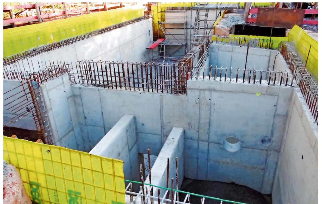
Die Baugrube für das neue Überlaufbecken mit den Maße 25x15x6 Meter hat das Wasser-Fassungsvermögen von 2500 Badewannen.
